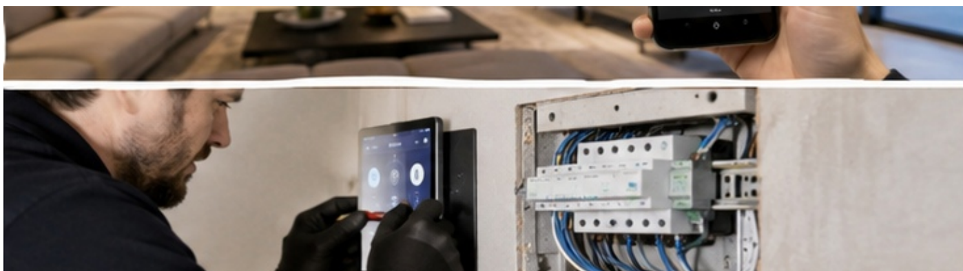
Foto 4 Preinstalación e instalación domótica: montaje de cableado, módulos de control y tablero para integrar los distintos sistemas del edificio.
