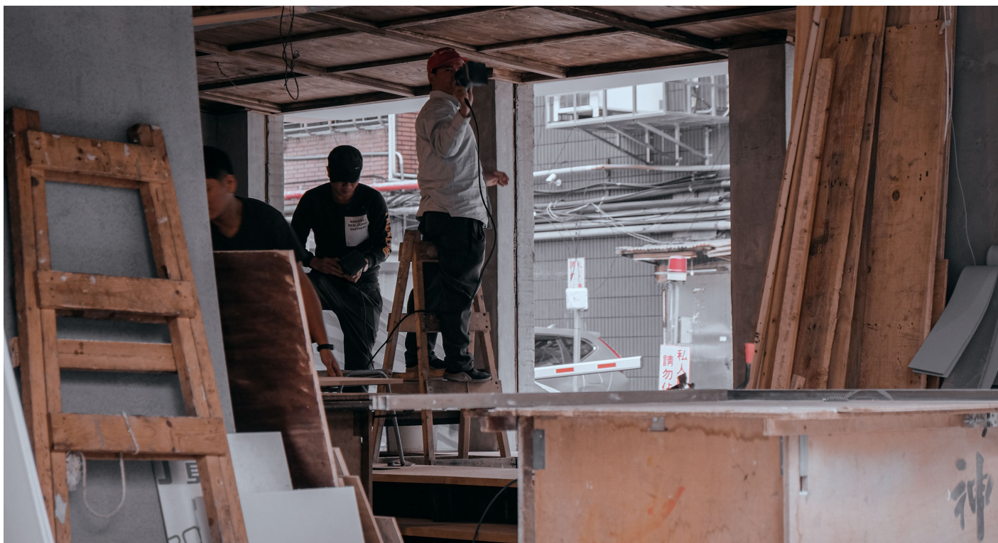
9. Trabajo colaborativo y montaje. La manipulación de paneles y estructuras exige coordinación, control de medidas y uso responsable de herramientas eléctricas durante la fabricación o instalación.
