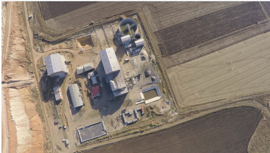
9. Planta de procesamiento: vista aérea de instalaciones destinadas a recibir, triturar, moler o concentrar minerales. La distribución de edificios y áreas de trabajo refleja la secuencia general del proceso productivo.
