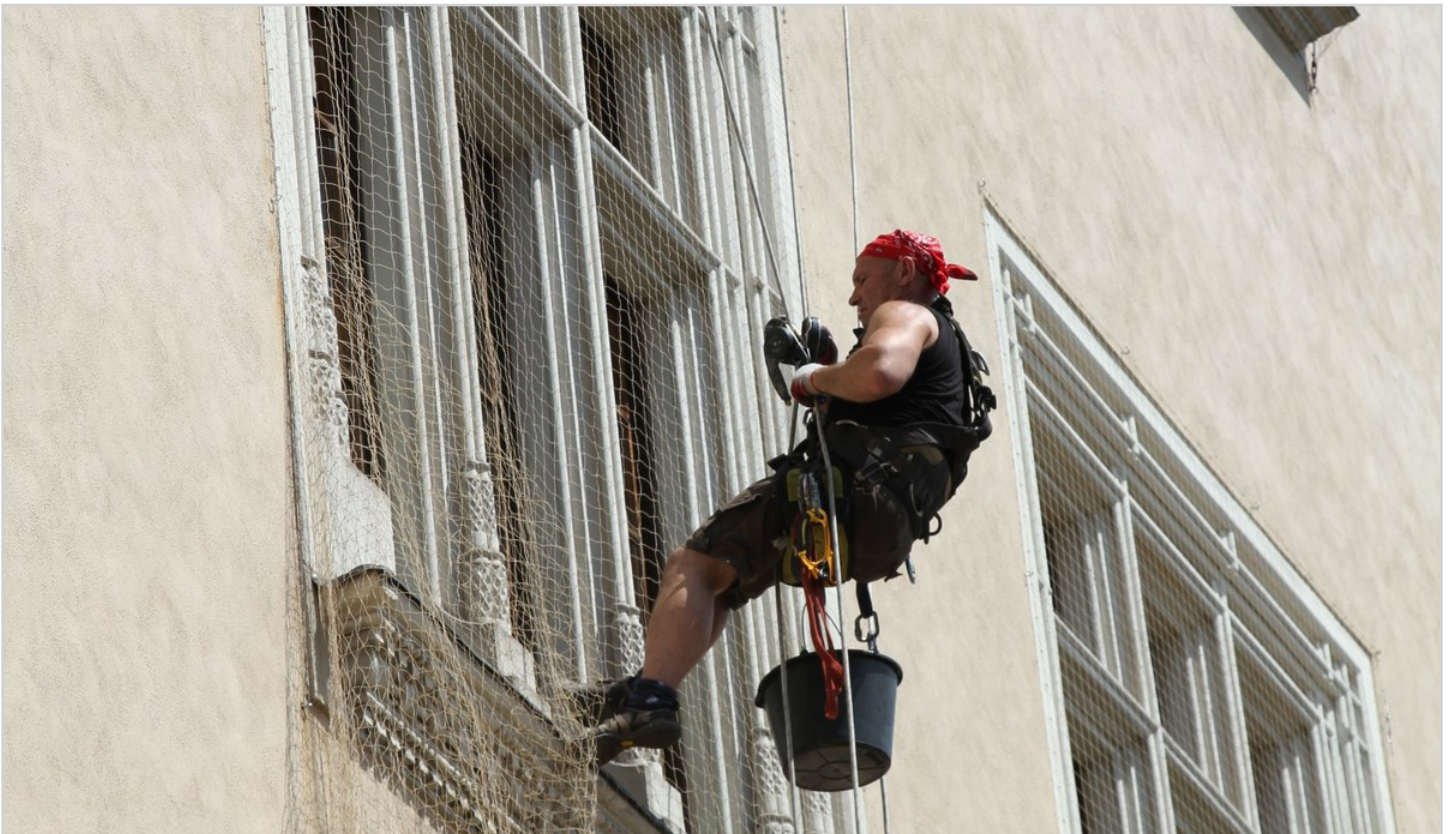
Foto 10 Operario realizando mantenimiento exterior mediante acceso por cuerdas. Representa tareas de inspección y mantenimiento en altura, donde la planificación, la comunicación y el control permanente del sistema de seguridad son esenciales.
