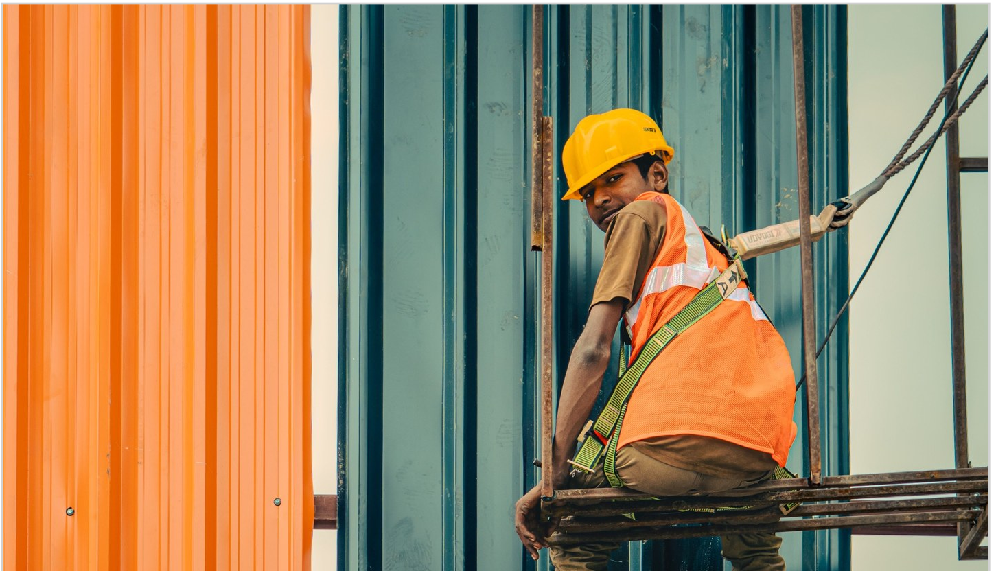
Foto 2 Operario trabajando sobre una estructura de andamio con casco, chaleco y arnés conectado. La escena permite abordar montaje de andamios, estabilidad, puntos de anclaje y prevención de caídas.
