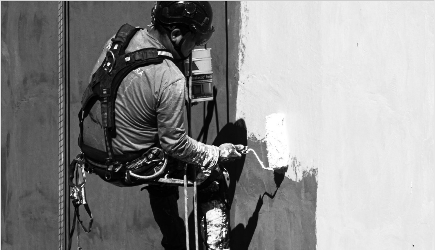
Foto 5 Especialista suspendido mediante cuerdas durante una tarea de mantenimiento vertical. Ejemplifica técnicas de acceso por cuerda, posicionamiento, anclajes y control del riesgo durante trabajos sin apoyo firme.
