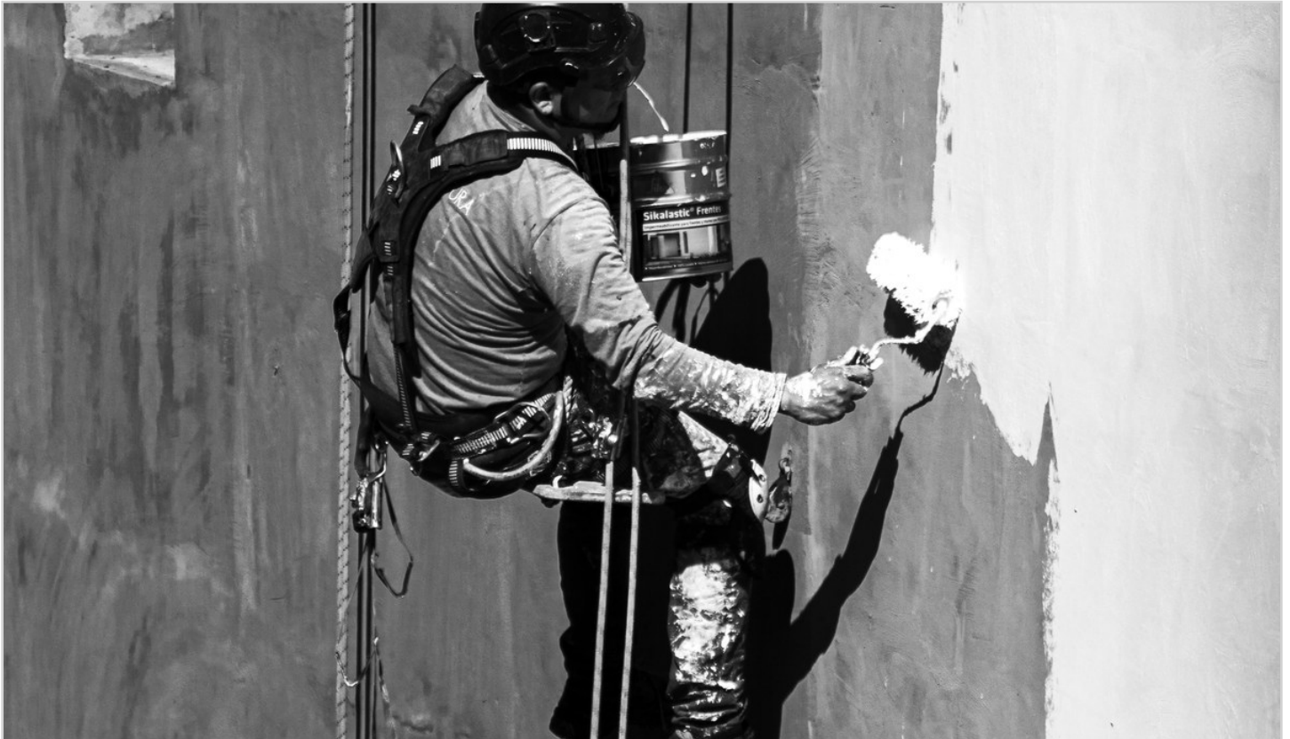
Foto 9 Trabajo vertical con arnés, cuerdas y equipo de posicionamiento. La escena sirve para estudiar la distribución del sistema anticaídas, las técnicas de suspensión y la importancia de verificar cada conexión.
