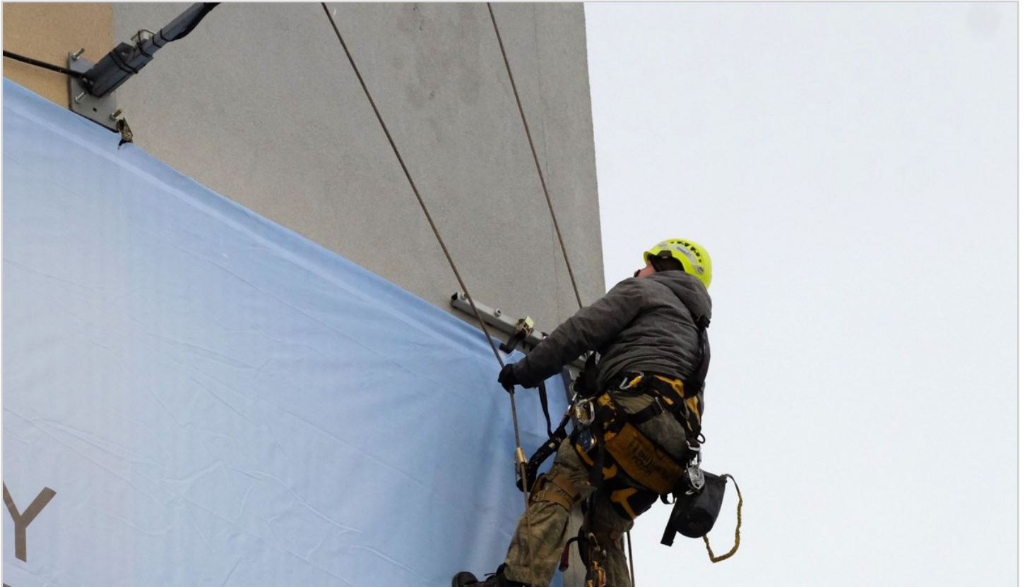
Foto 7 Técnico escalando una fachada mediante cuerdas y equipos de progresión vertical. La fotografía ilustra sistemas de ascenso, líneas de vida, posicionamiento y control de herramientas en tareas de altura.
