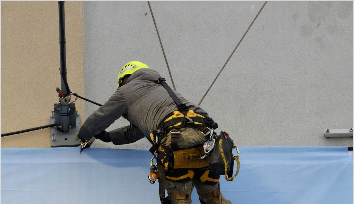
Foto 1 Trabajo técnico en altura sobre fachada, con casco, arnés y sistema de sujeción. Representa la evaluación de riesgos, el uso de equipos de protección y la aplicación de procedimientos seguros en tareas elevadas.
