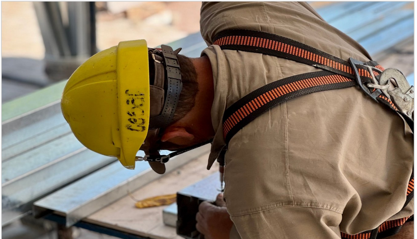
Foto 3 Trabajador de obra realizando mediciones sobre componentes metálicos con protección personal. Vincula el control dimensional, la interpretación del montaje y la verificación de estructuras antes de su fijación.
