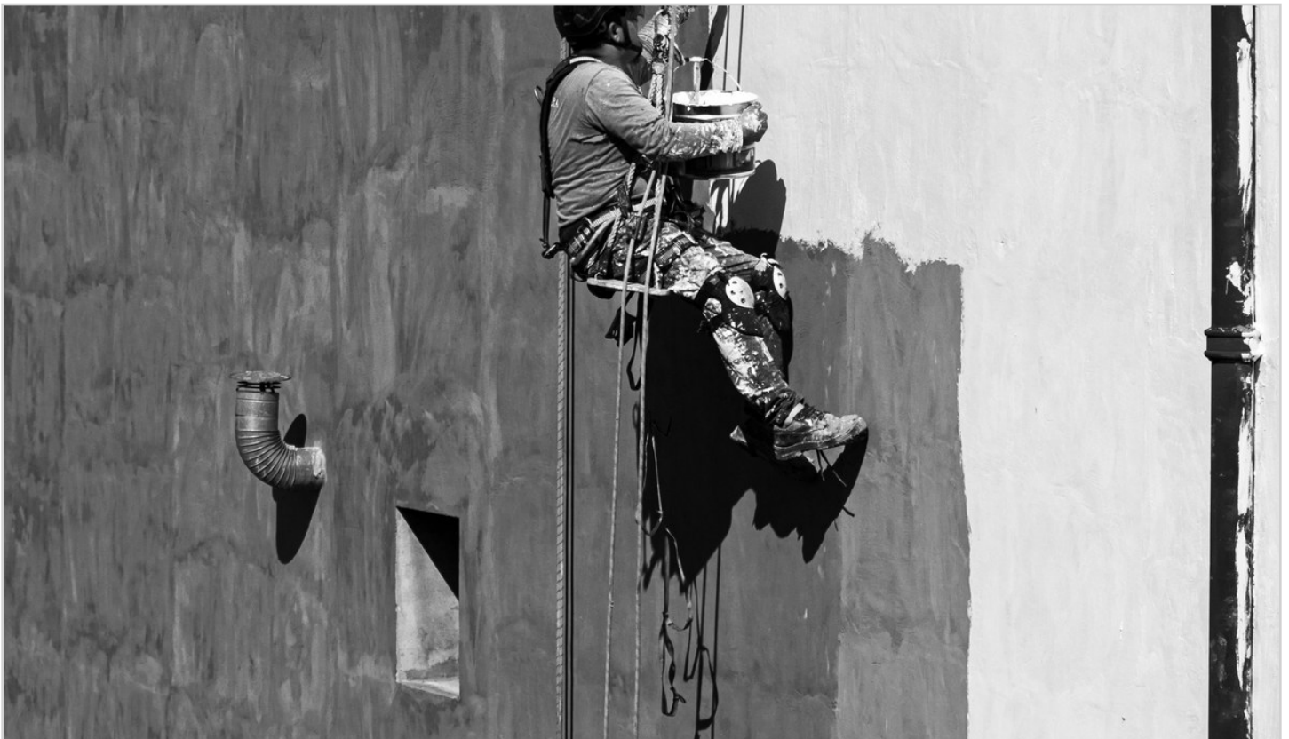
Foto 8 Profesional suspendido con cuerdas durante mantenimiento de una fachada. Se observan varios elementos de seguridad que permiten trabajar conceptos de redundancia, conexión, anclaje y organización del equipo.
