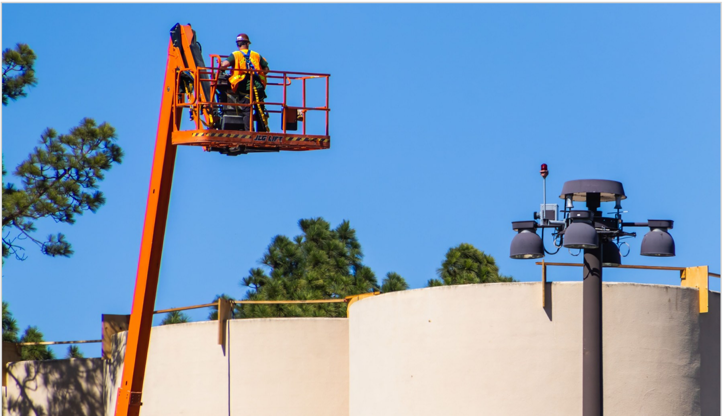
Foto 6 Operario trabajando desde una plataforma elevadora en altura. Permite analizar el uso seguro de plataformas de trabajo, delimitación de la zona, planificación de maniobras y medidas preventivas frente a caídas.
