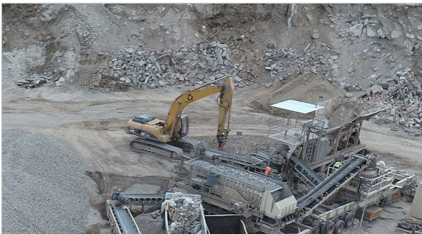
Foto 6. Instalación de trituración y clasificación de hormigón. Los residuos minerales se reducen de tamaño para producir materiales que pueden reutilizarse como bases, rellenos o áridos reciclados.
