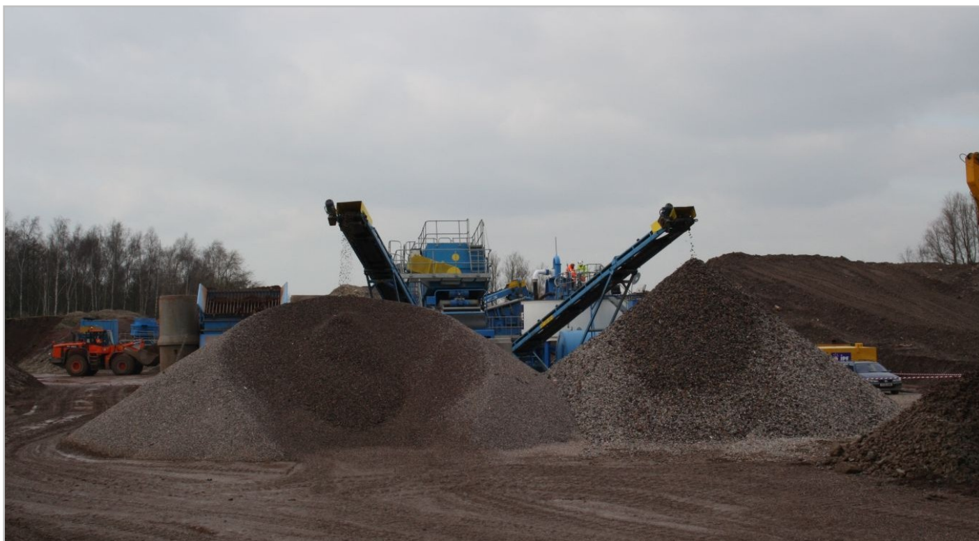
Foto 7. Acopios de áridos reciclados obtenidos tras el tratamiento de residuos. La clasificación granulométrica permite destinar cada fracción a diferentes aplicaciones constructivas.
