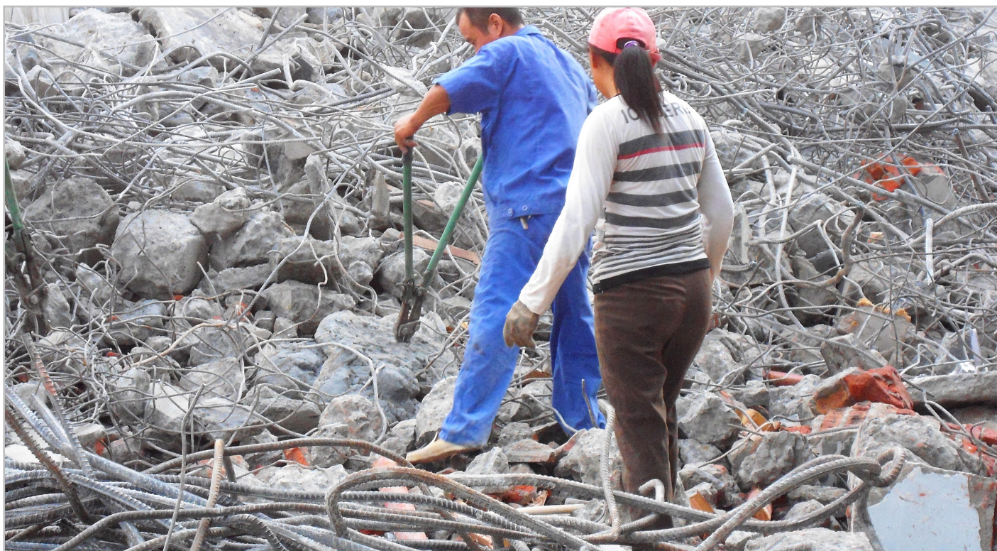
Foto 3. Recuperación de acero de refuerzo entre fragmentos de hormigón. La separación de metales es una etapa clave para valorizar los residuos y evitar contaminaciones en los áridos reciclados.
