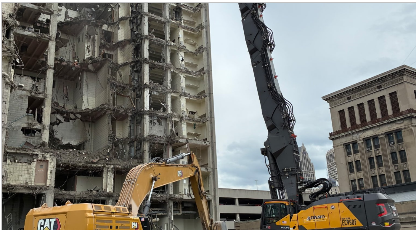
Foto 5. Excavadora de brazo largo trabajando sobre un edificio en demolición. Este tipo de equipo permite intervenir estructuras de gran altura manteniendo una distancia operativa más segura.
