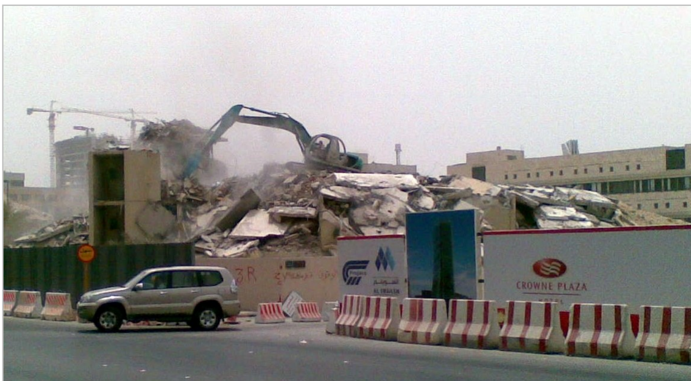
Foto 4. Demolición controlada de una estructura mediante excavadora. La planificación del derribo ayuda a ordenar los materiales, mejorar la seguridad y favorecer su posterior clasificación.
